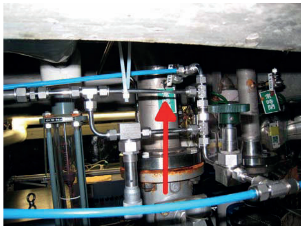
図3 つぶした配管付近（矢印がつぶした所）
