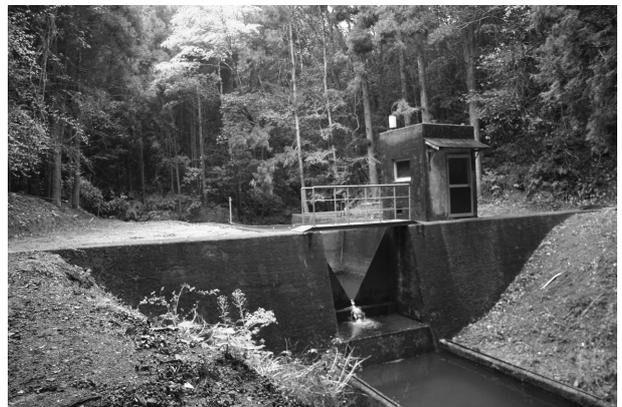
写真-2 III号沢の量水堰堤
