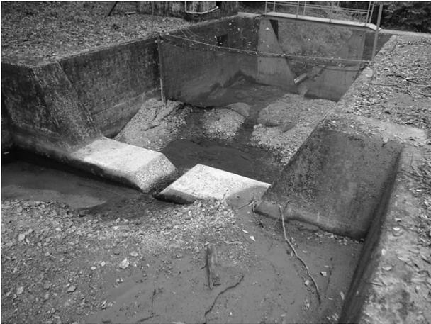
写真-5 2005年14号台風の豪雨によって満砂となったII号沢の量水堰堤 (2005年9月撮影)
