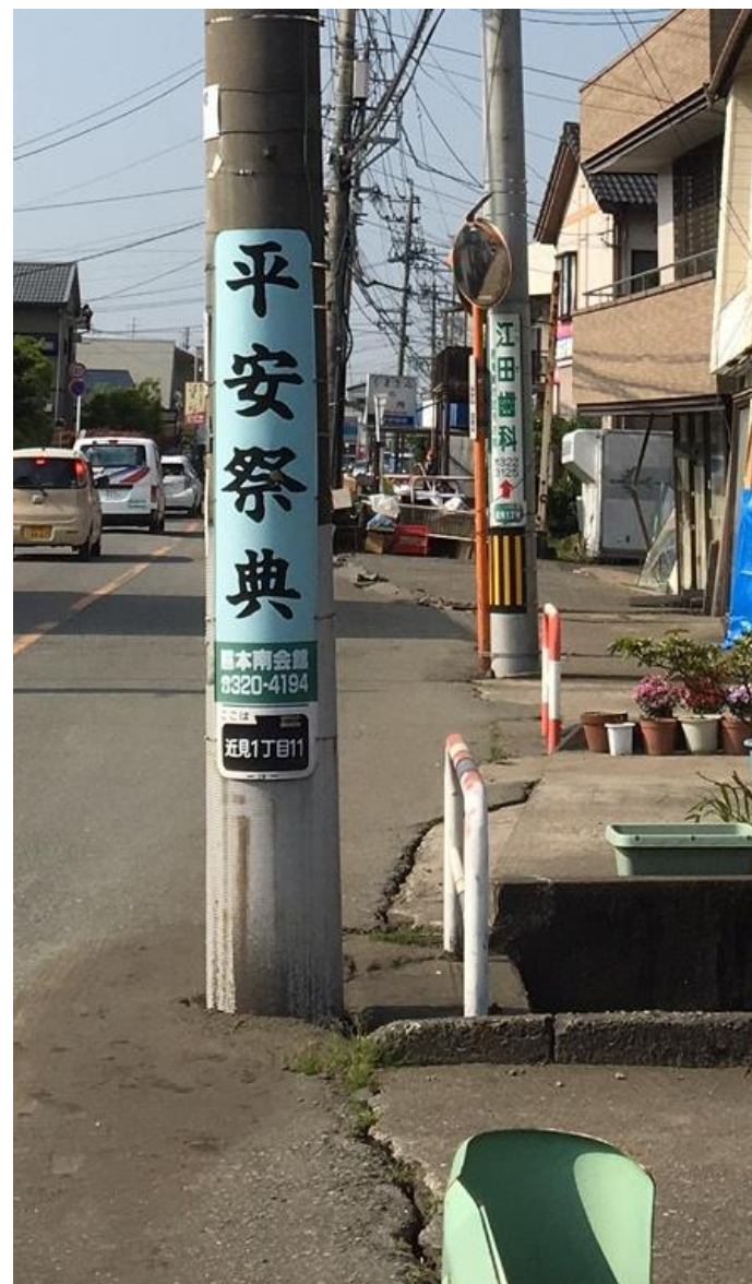
熊本市南区近見一丁目 液状化による電柱の沈下 約1m 清田様 写真提供
