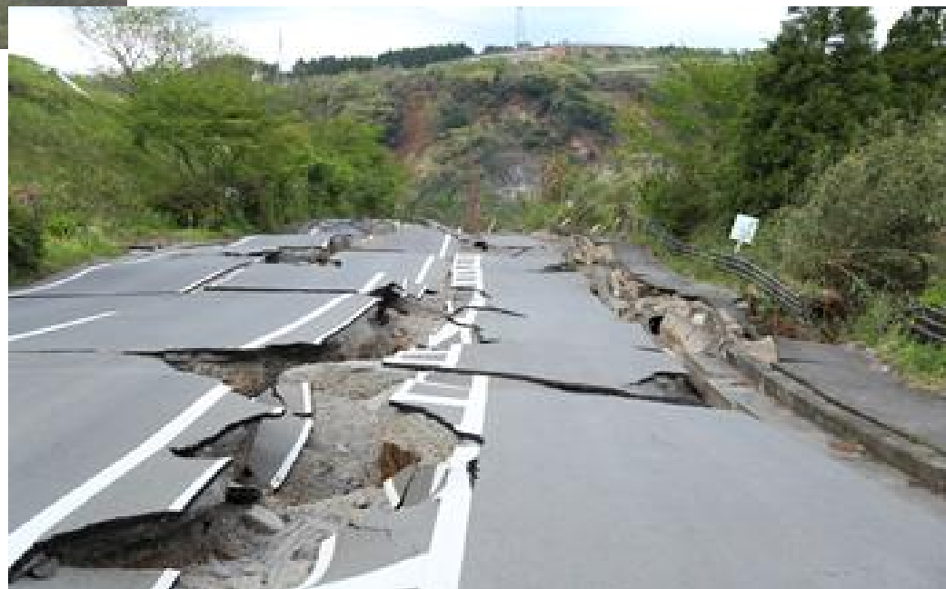
路面のひび割れ
