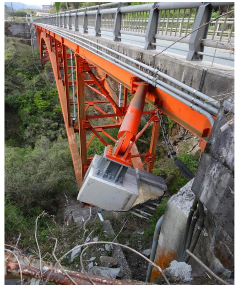
ダンパーの取り付け部の損傷
