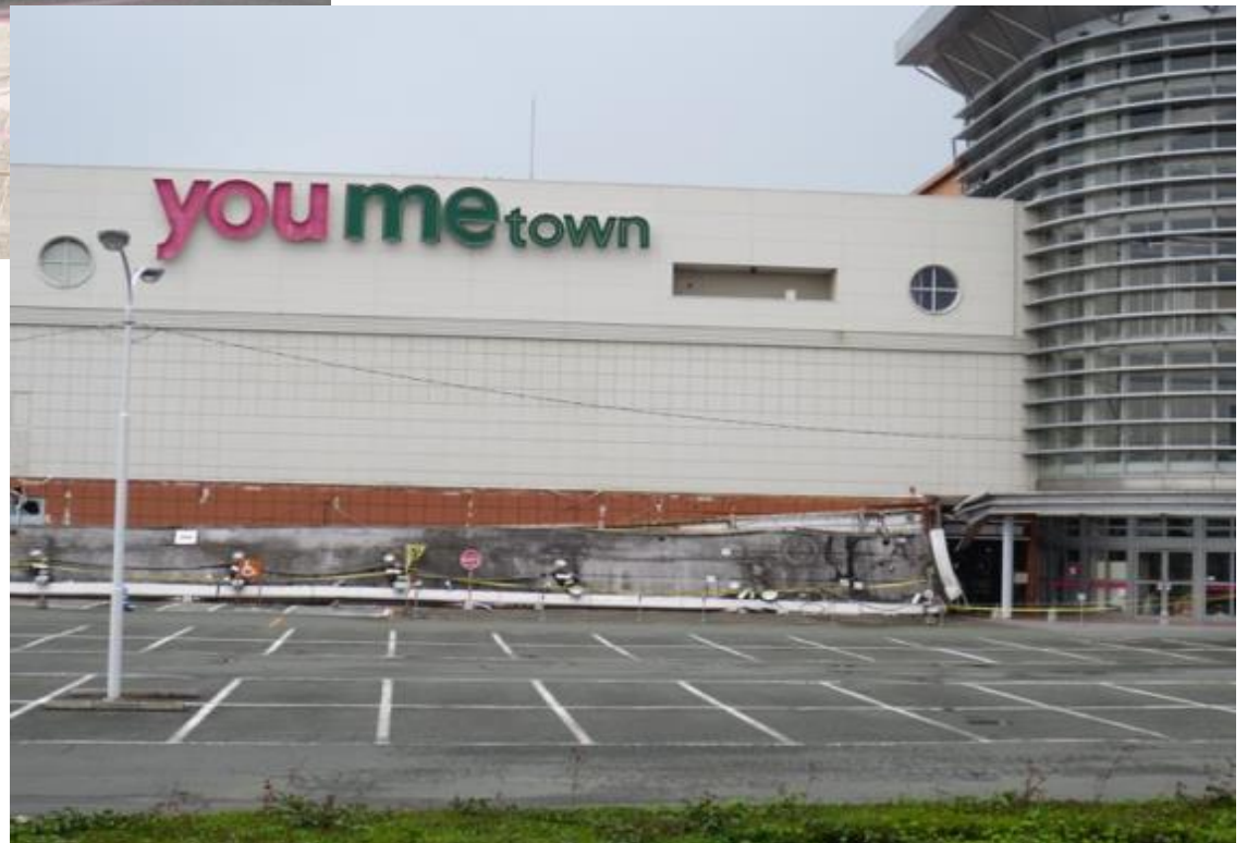
1階の屋根が崩落したサンピアンモール
