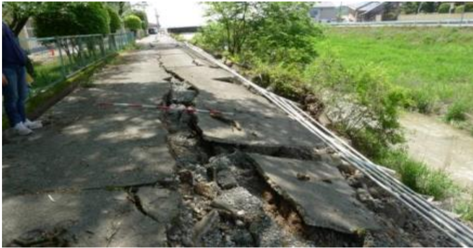
天端において縦断亀裂の発生
