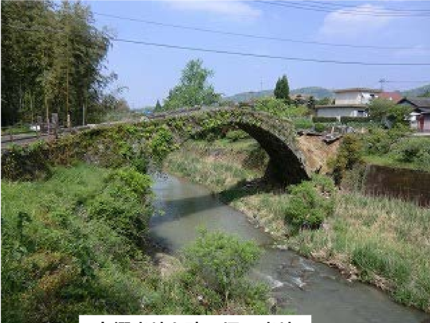
高欄崩壊と壁石垣の崩壊
