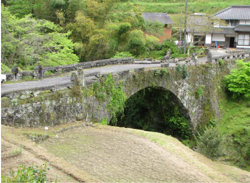
高欄崩壊と落下状況
