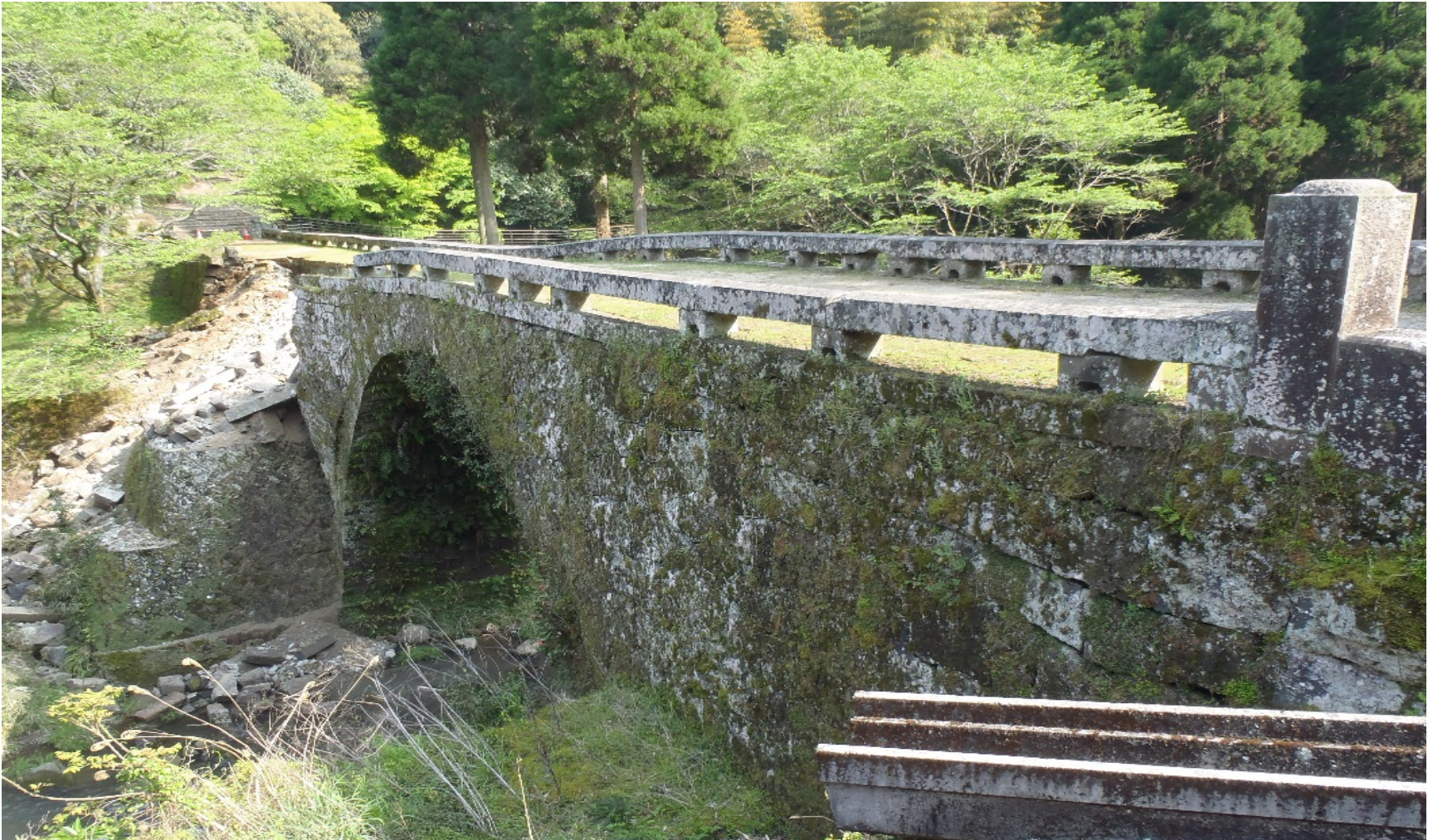
アーチ輪石と崩壊した壁石垣
