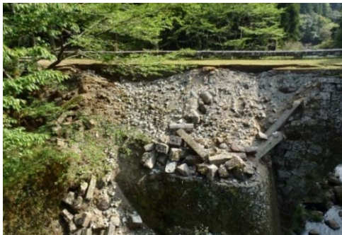
(a)地震での壁石崩壊状況
