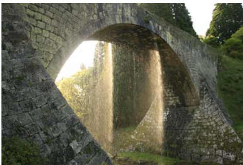
(a)地震での被災状況（漏水と被覆土の亀裂）
