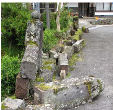
(a)永山橋の高欄の被災状況
