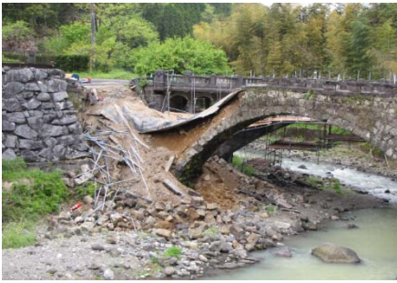
(a)地震での壁石崩壊した被災状況
