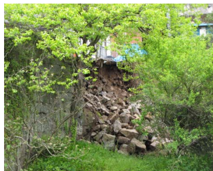
(b)立門橋の壁石崩壊状況
