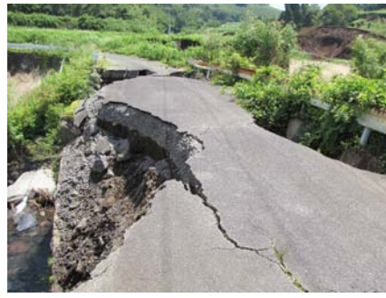
(b) 路面からみた流壁石の崩壊状況
