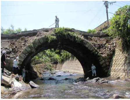
(a) 上下流側から崩壊状況
