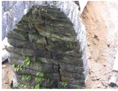
(a)地震での壁石崩壊した被災状況
