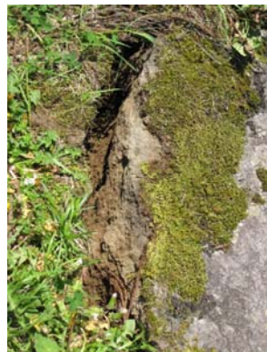
(a)地震での被災状況（漏水と被覆土の亀裂）
