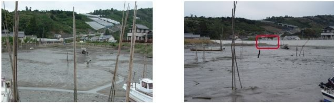
図9 調査地写真．左は2001年5月撮影．右は2005年12月撮影．右の写真の赤枠が今回の堤防工事区域．右の写真では堤防が完成し，ヨシ原が大幅に減っている．
