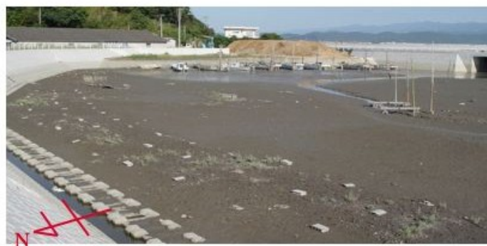
図13 人工シェルター設置の様子
