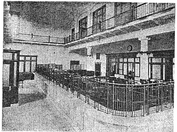
図3 竣工写真 (内部)
