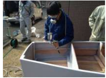
c) サーフェイサー 面仕上げの最終チェック
