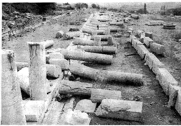
写真3 東ストアと倒れた外部列柱
