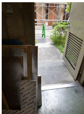
図2. 扉傍の突き出た板材の角
