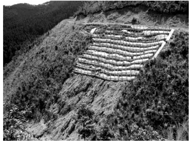
写真 - 3 権現山伐採地における最大規模の林道路肩崩壊(幅 30 m, 高さ 40 m 程度)。
