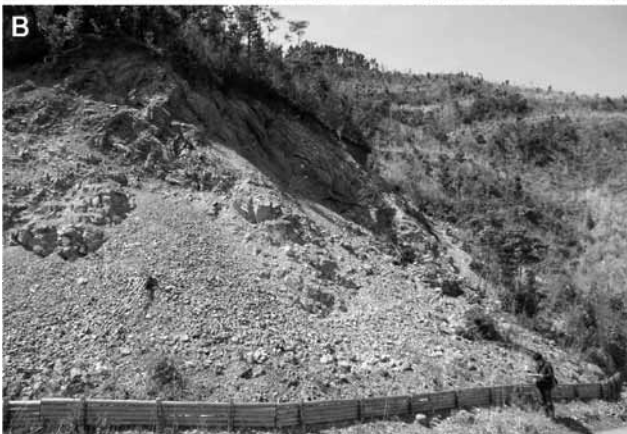
写真 - 2 権現山皆伐跡地内の流れ盤斜面における切り取りのり面の崩壊。(A) 作業路沿いの小規模な崩壊。(B) 林道沿いの最大規模の崩壊(幅 30 m, 高さ 12 m 程度)。
