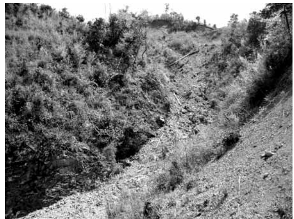
写真 - 4 伐採地内の谷筋における土砂移動状況
