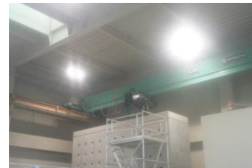
写真1 構造材料実験室の点検状況
