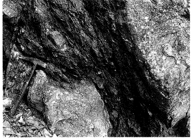
写真② 青峰層群と松尾層群の境界部の断層破碎帯
