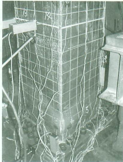
写真 5-5 LNI-46 北西側の溶接割れ状況
