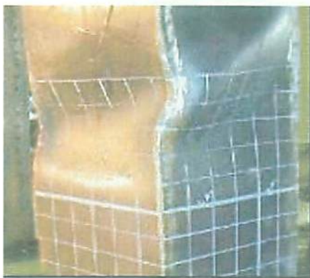
写真 4-1 無補剛中空断面部での座屈波形
