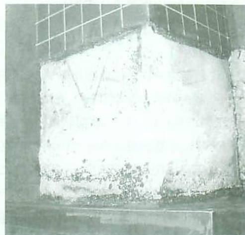
b) 内部コンクリート
