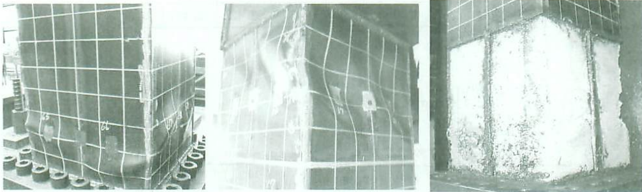
a) 柱基部(南西)
