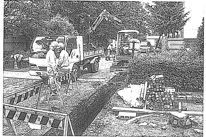
写真 51 9905 地点立会掘削風景(北西より)
