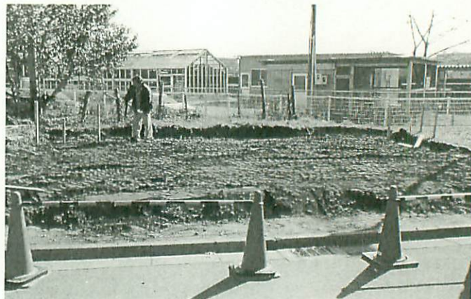
写真33 掘削状況（西より）
