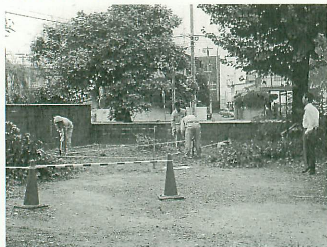
写真37 作業風景（北より）
