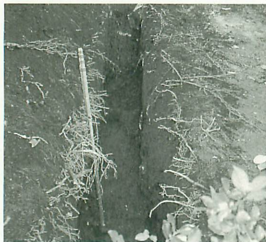
写真31 掘削状況（西より）
