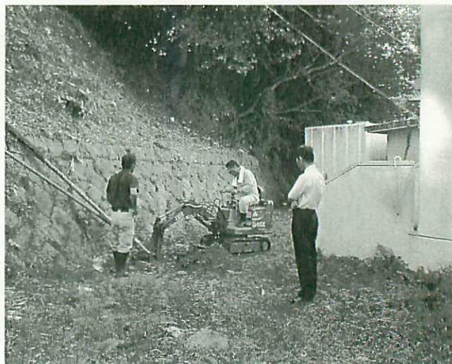
写真52 作業風景（北西より）
