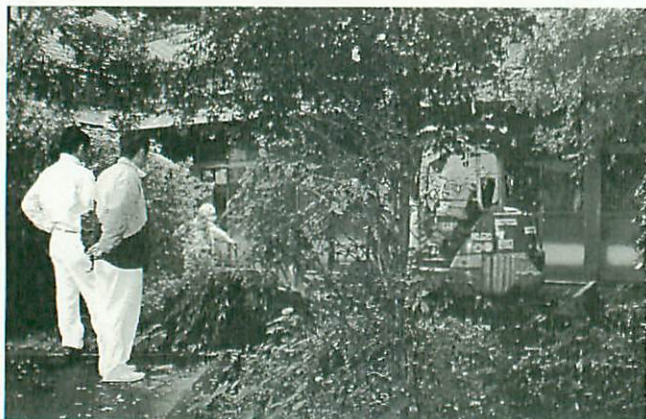
写真48 作業風景（北より）
