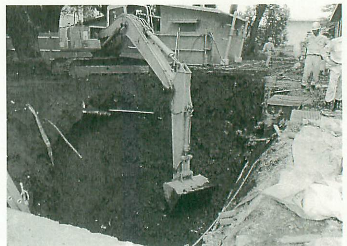
写真30 作業風景 (東より)
