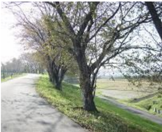
写真-10 輪中堤天端の道路
