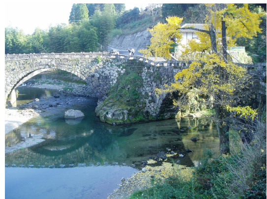
写真-1 二俣二橋
