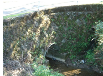
写真-4 コンクリート補強の石橋
