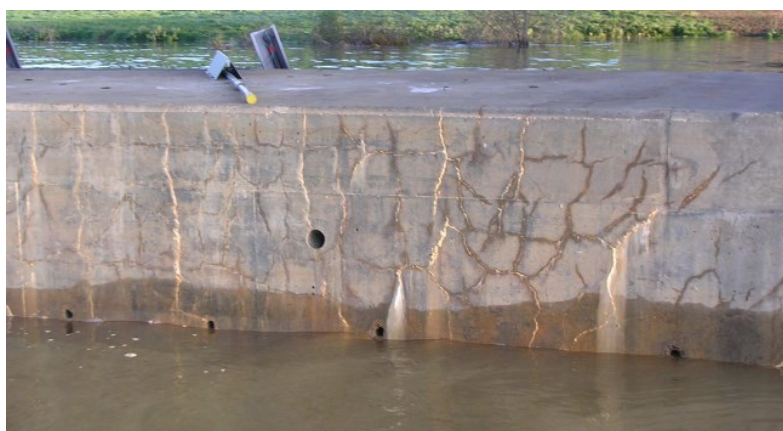
写真 3-1 DEF が発生したコンクリートのひび割れ 3-1)
