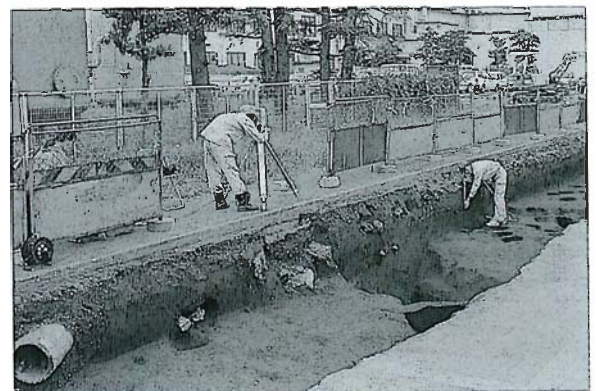
写真16 測量風景(北東より)
