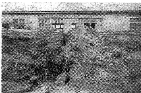
工業化学実験室の泥位(水位は窓の線)
