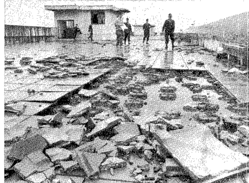
工学部1号館屋上の敷石は投石用にはがされていた（熊日提供）
