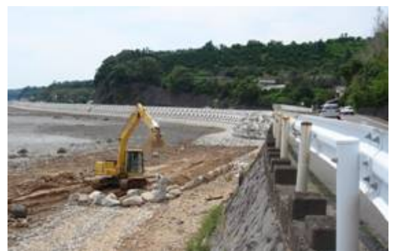
写真-1 高潮災害後の不知火海岸の復旧工事: 防災機能が向上する一方で、沿岸道路の景観や干潟の減少により生物生息場が消失
