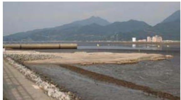
写真-2 熊本新港に造成した「なぎさ線」:人工護岸前面に「なぎさ線」を造成して地形の連続性と生態系の連続性を創出
