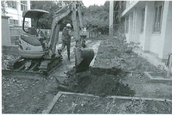
写真195 中庭調査区表土剥ぎ（東より）
