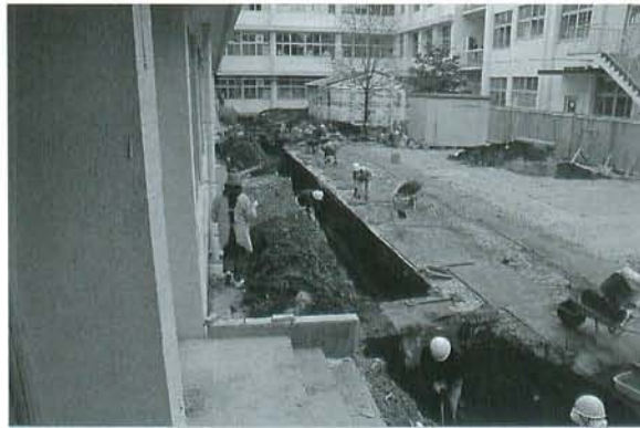
写真197 中庭調査区調査風景2（西より）
