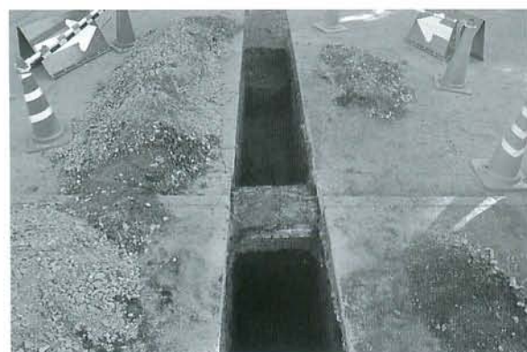
写真213 構内中央道路調査区西側完掘状況1（西より）
