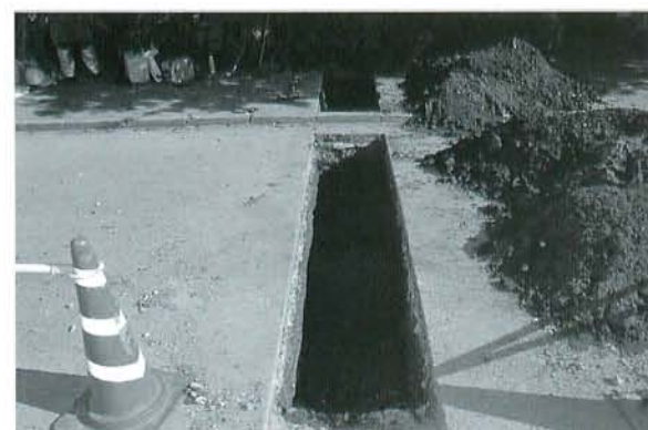
写真215 構内中央道路調査区東側完掘状況（西より）
