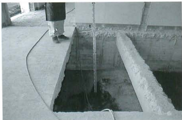
写真187 中学校校舎内調査区西側試掘（西より）
