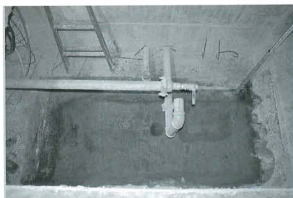
写真192 中学校校舎内調査区南側完掘状況（東より）
