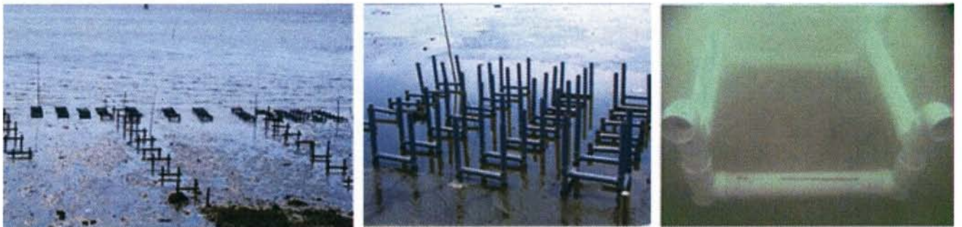
写真 3.3.2 設置状況 (左:干潟域遠景, 中:干潟域近景, 右:海域近景)
