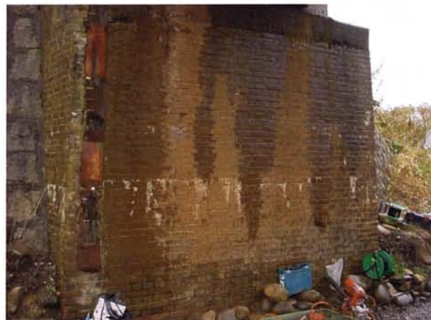
写真-7.3 レンガ構造の橋台（根室本線 乙部川橋梁）
