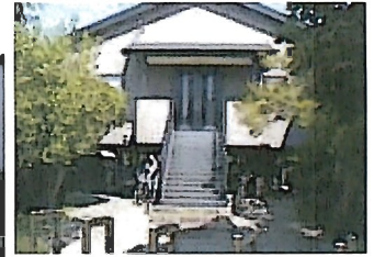
写真-2 ピロティ建築
