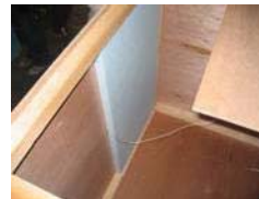
図7 断熱材の施工
