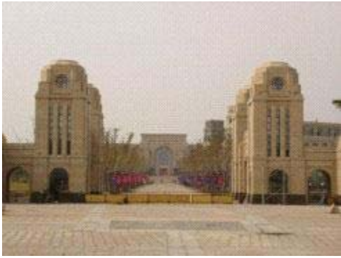
図-3 建設中の復旦大学の新キャンパス
