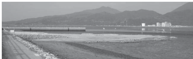
写真-3 熊本港「東なぎさ線」
