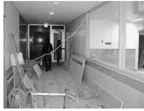
33) GCU廊下2工事壁面
