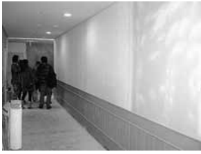
32) 小児病棟への廊下5工事壁面
