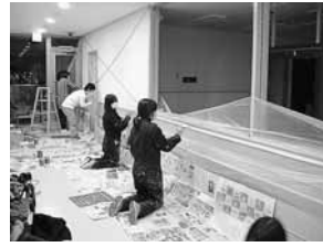
34) GCU廊下2養生
