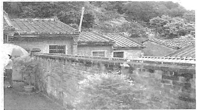
写真2 塀の外は段差があり、低くなっている。1室1屋根（床の段差なくても）
