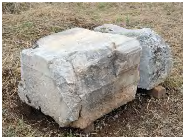
4. トイコベート部材 (プロナオス及びオピストドモス側面壁用) ΔX8
