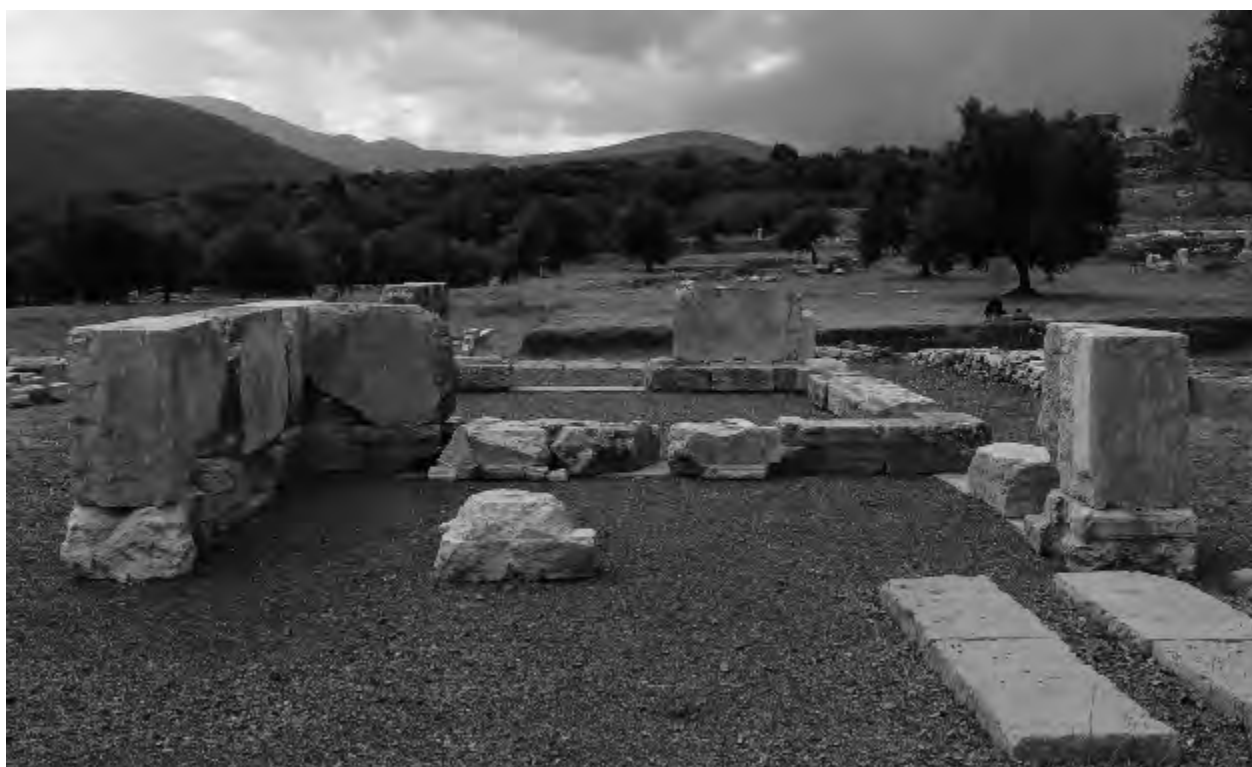
2. 内陣、東からの全景（復元後）
