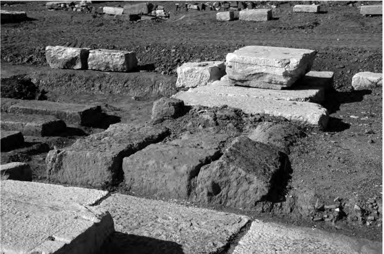
2. 東側スロープの基礎
