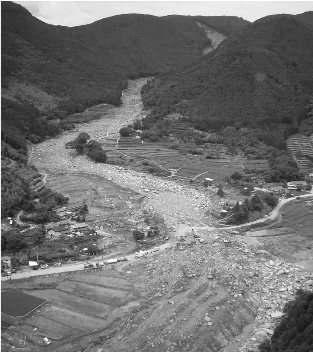
写真 2. 6 土石流発生後斜め写真（平成 15 年 7 月 21 日）
