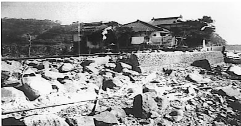
写真 2. 3 永尾地区の被災状況
