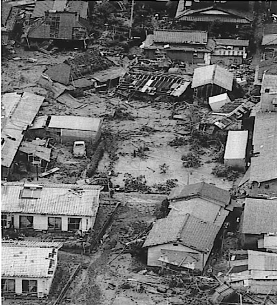
写真 2. 2 松合地区の被災状況
