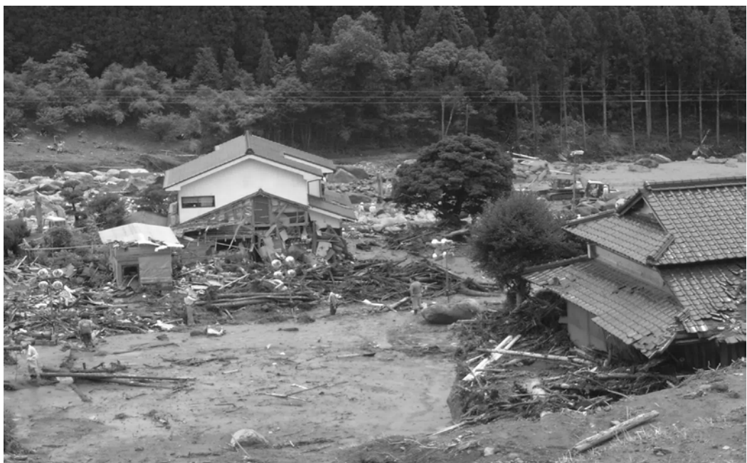
写真 2. 7 土石流により被災した家屋
