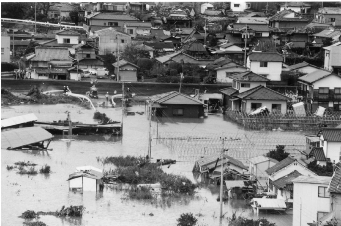
写真 2. 4 松合地区の浸水状況
