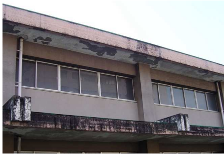
図 1.1 改修前の高窓
