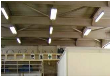
図 2.1 改修前の照明器具（蛍光灯）
