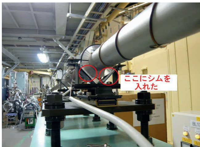
図 16 ダクトの傾け方法
