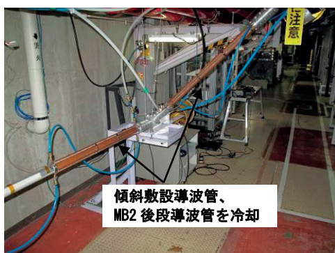
図6 銅製冷却ジャケット
