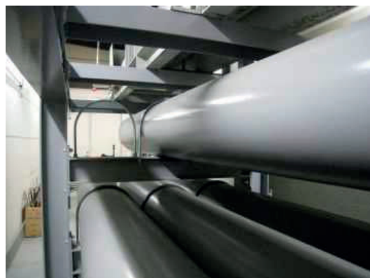
図 2 3 新設された長尺ボンベ
