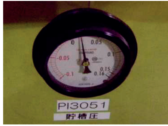
図 2 6 液体ヘリウム貯槽圧力計の位置：低くて見づらい。目線の高さに設置すれば良かった。
