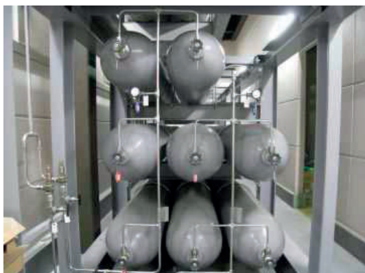
図 2 3 新設された長尺ボンベ
