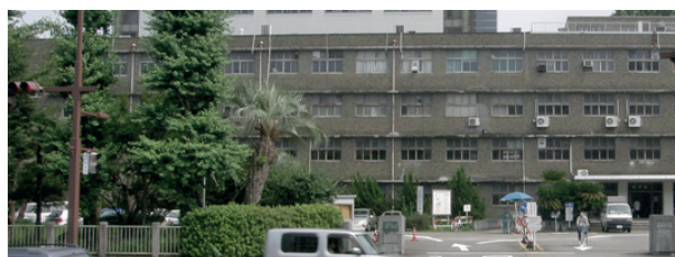
写真1 医学部 旧基礎研究棟
