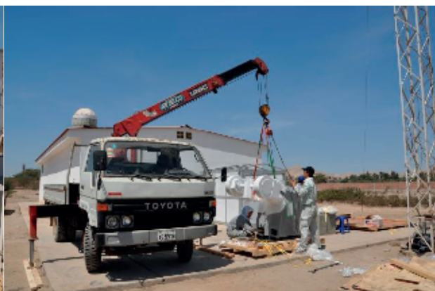
設置作業状況
