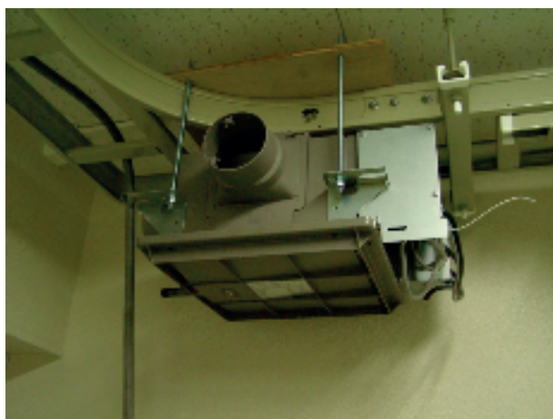
図7 排気ファンのケーブルラックに取り付け
