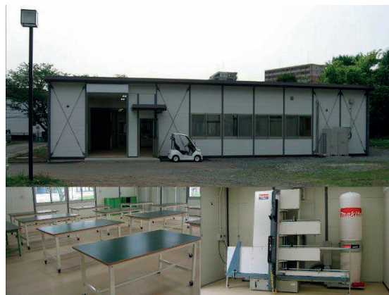
図4 増設部（新棟）の外観と内部
