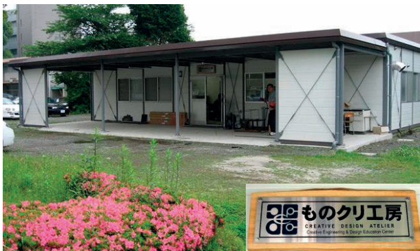
図1 ものづくり創造融合工学教育事業拠点工房 「ものづくり工房」外観と看板
