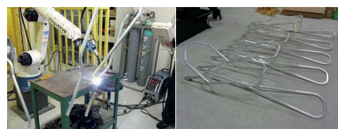
写真-10 車体フレーム溶接
