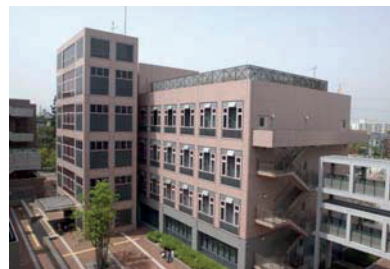
図1 基礎教育実験棟 外観
