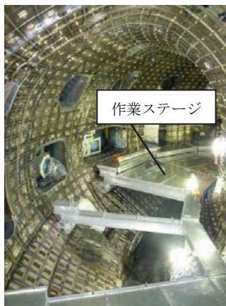
図 5 タイル取外し後の VV 内全景
