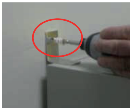
写真 2 ドライボードアンカー（新製品） 図 2 ウ）, エ）の過程が省かれる
