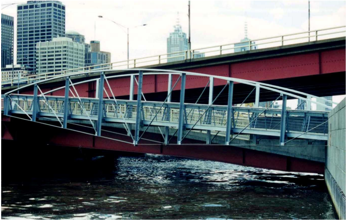
写真 1-1 ヤラ川に架かる橋梁（オーストラリア メルボルン）
