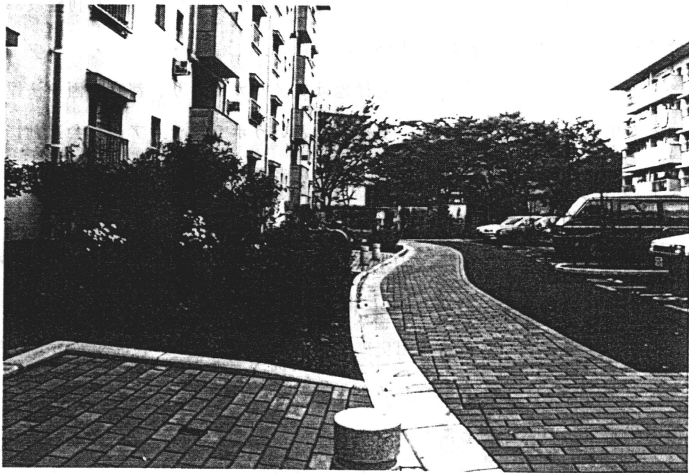
写真-10 完成した2街区 - 駐車場がゆるやかにカーブを描く
