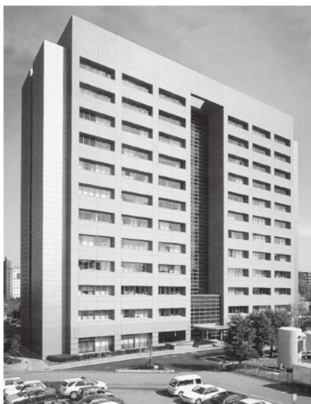
写真2 基礎医学研究棟
