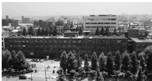
写真6 旧基礎研究棟遠景
