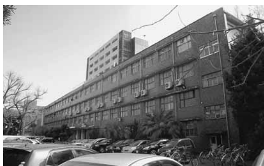
写真7 取り壊される旧基礎研究棟
