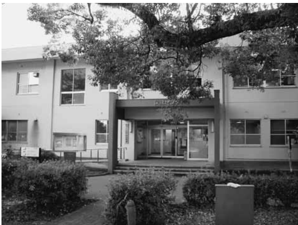
写真1 保健センター棟全景 1階が保健センター
